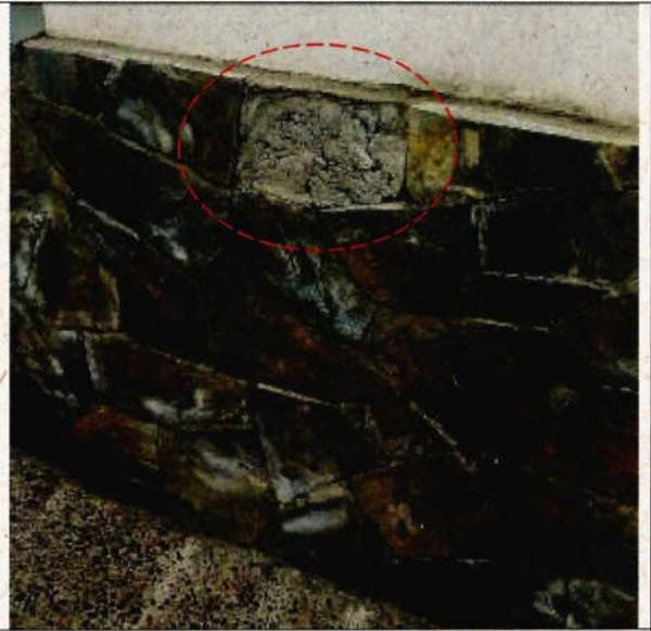
Fotografía N°26 – “Reposición terminal de Buses de Peumo” Desprendimiento del material utilizado para el recubrimiento del zócalo del muro perimetral a un costado de acceso principal al Terminal.
