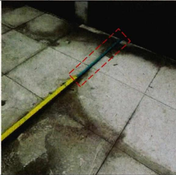
Fotografía N°37 - "Reposición terminal de Buses de Peumo" – Tubería de gas para alimentar calefont sin una protección que impida daño físico o mecánico.
