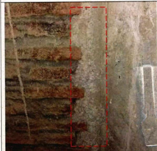
Fotografía N°11 - "Reposición y Restauración Parroquia Natividad de María, comuna de Lolol" – Nidos de piedra en unión entre pilares de Hormigón Armado y albañilería en estructura de Campanario.
