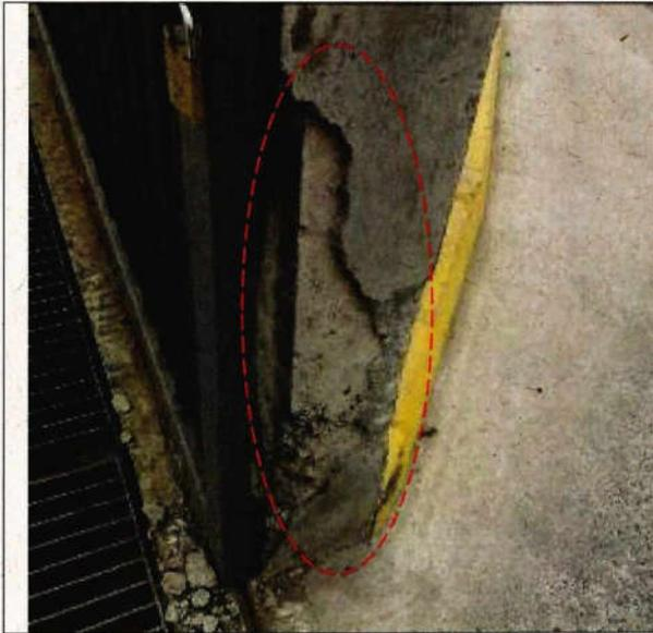
Fotografía N°25 – “Reposición terminal de Buses de Peumo” Desprendimiento del material utilizado para el recubrimiento del muro de hormigón que soporta el Portón de corredera en el Acceso Vehicular.
