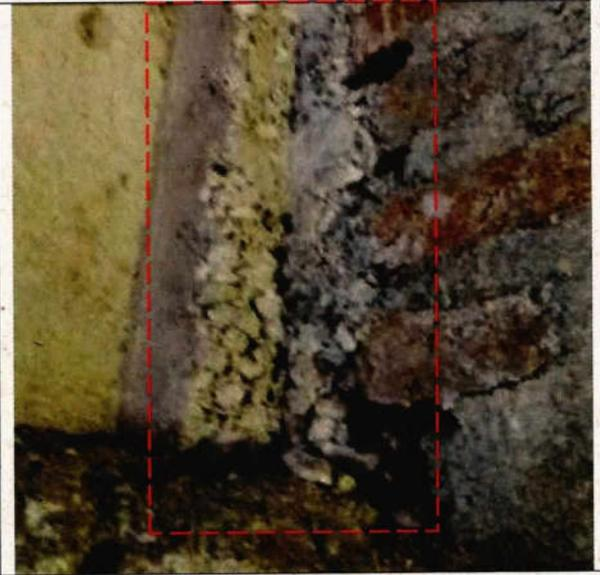
Fotografía N°12 - "Reposición y Restauración Parroquia Natividad de María, comuna de Lolol" – Nidos de piedra en unión entre pilares de Hormigón Armado y albañilería en estructura de Campanario.
