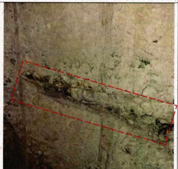
Fotografía N°16 - "Reposición y Restauración Parroquia Natividad de María, comuna de Lolol" – enfierradura a la vista en pilar de Hormigón Armado en estructura de Campanario
