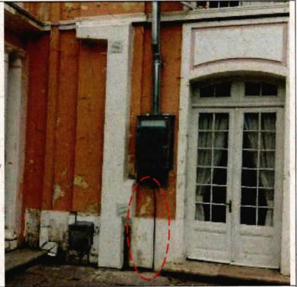
Fotografía N°34 - "Conservación Hogar Estudiantil Junaeb Cunaquito" – Tubería de gas para alimentar calefont sin pintar.
