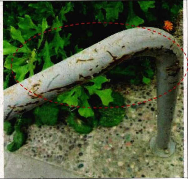
Fotografía N°22 – “Reposición terminal de Buses de Peumo” – Desprendimiento de pinturas en Estacionamiento de bicicletas.
