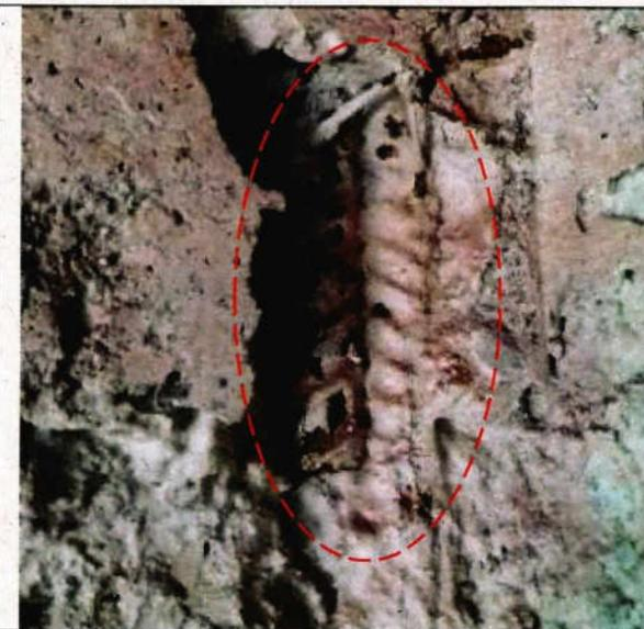
Fotografía N°15 - "Reposición y Restauración Parroquia Natividad de María, comuna de Lolol" – enfierradura a la vista en pilar de Hormigón Armado en estructura de Campanario
