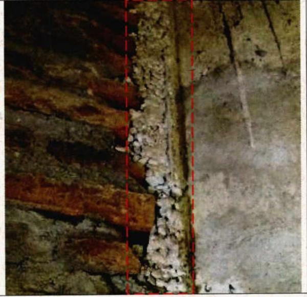
Fotografía N°10 - "Reposición y Restauración Parroquia Natividad de María, comuna de Lolol" – Nidos de piedra en unión entre pilares de Hormigón Armado y albañilería en estructura de Campanario.
