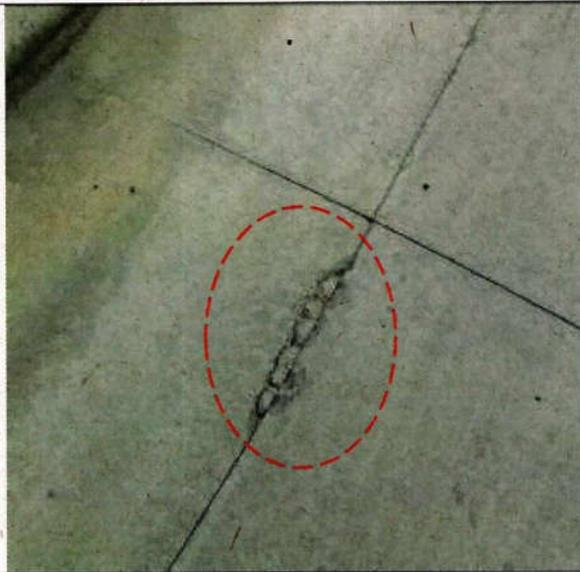
Fotografía N°5 – “Reposición terminal de Buses de Peumo” – Desprendimiento de Hormigón en radier del Patio de maniobras.
