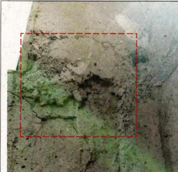
Fotografía N°17 - "Reposición y Restauración Parroquia Natividad de María, comuna de Lolol" – deformación en pilar de Hormigón Armado en parte superior de Campanario.
