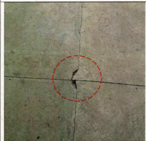
Fotografía N°3 – “Reposición terminal de Buses de Peumo” – Desprendimiento de Hormigón en radier del Patio de maniobras.
