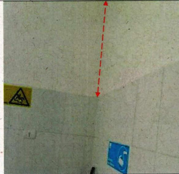
Fotografías N°44 y 45 - "Conservación Hogar Estudiantil Junaeb Cunaquito" – Cerámica de muro sin llegar hasta cielo baños.
