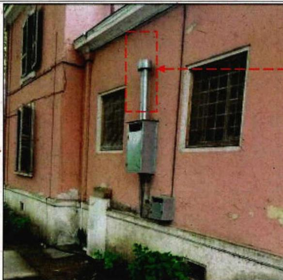
Fotografía N°39 - "Conservación Hogar Estudiantil Junaeb Cunaquito" – Conducto de evacuación de gases por fachada principal de edificación.
