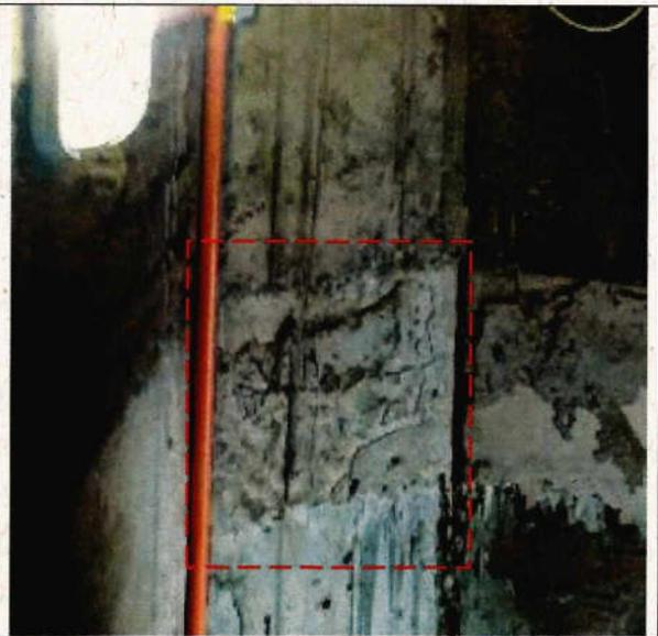
Fotografía N°18 - "Reposición y Restauración Parroquia Natividad de María, comuna de Lolol" – deformación en pilar de Hormigón Armado.
