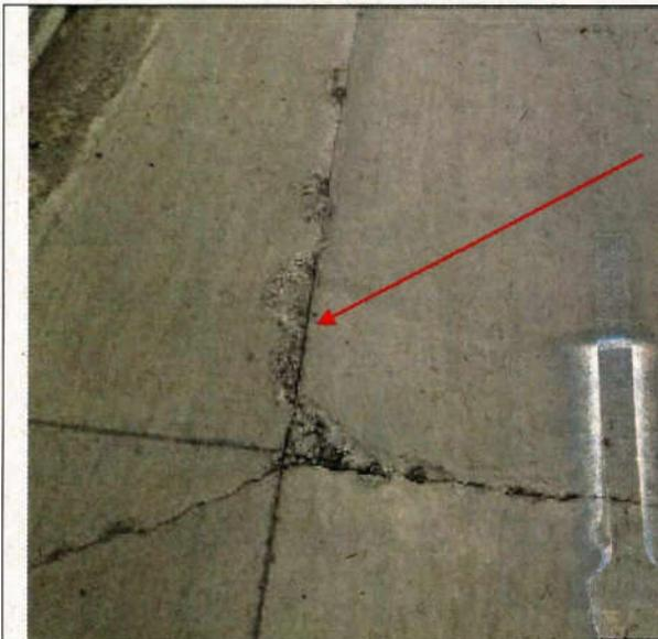
Fotografía N°1 – “Reposición terminal de Buses de Peumo” – Fisura y desprendimiento de Hormigón en radier del Patio de maniobras.
