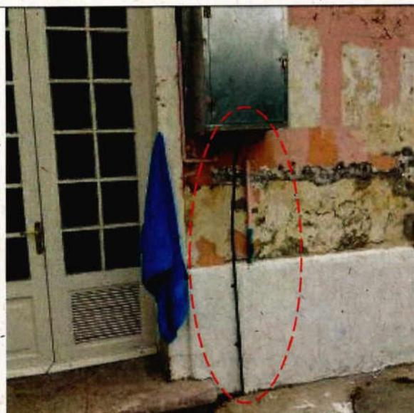
Fotografía N°35 - "Conservación Hogar Estudiantil Junaeb Cunaquito" – Tubería de gas para alimentar calefont sin pintar.
