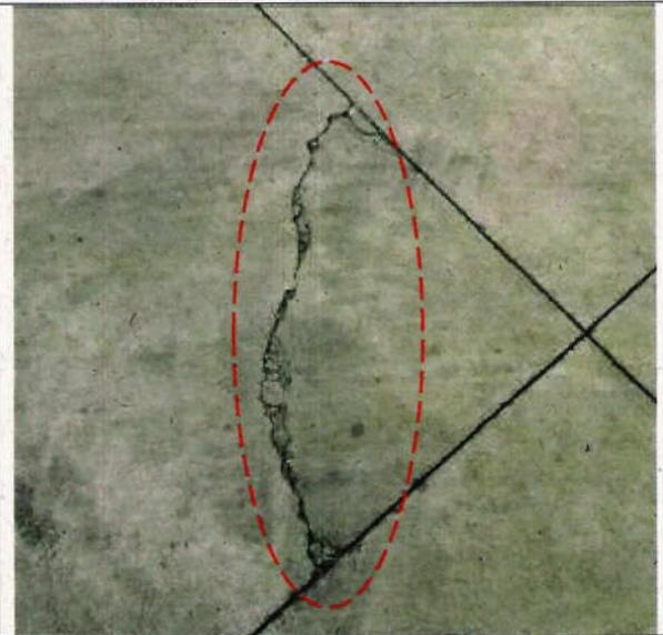
Fotografía N°8 – “Reposición terminal de Buses de Peumo” – Fisura de Hormigón en radier del Patio de maniobras.
