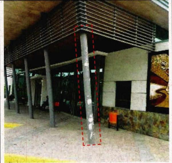
Fotografía N°24 – “Reposición terminal de Buses de Peumo” Desprendimiento de pinturas en Pilar de acero estructural ubicado en sector Andenes.
