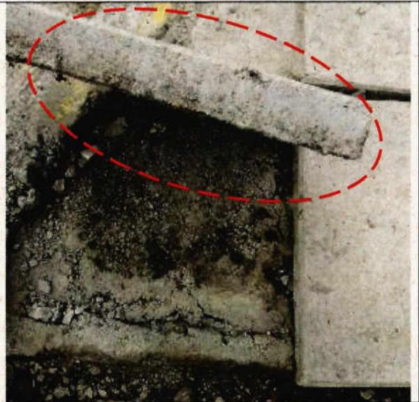
Fotografías N°27 y 28 – “Reposición terminal de Buses de Peumo” baldosas sueltas en la intersección de calle Vicuña Mackenna con el Acceso Vehicular al Terminal de Buses.
