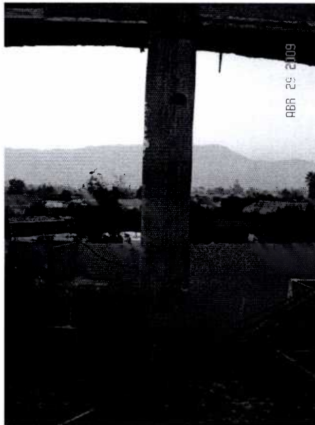
Pilar desaplomado y deformado
