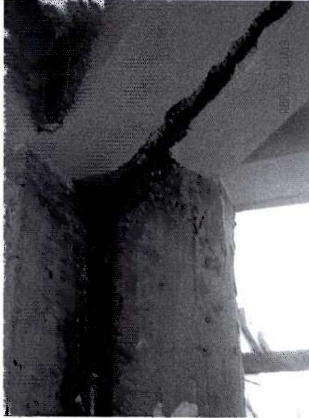
Encuentro viga- pilar y muro
