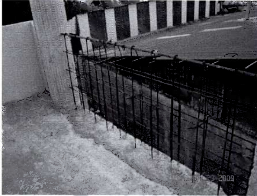
Partida de baranda inconclusa
