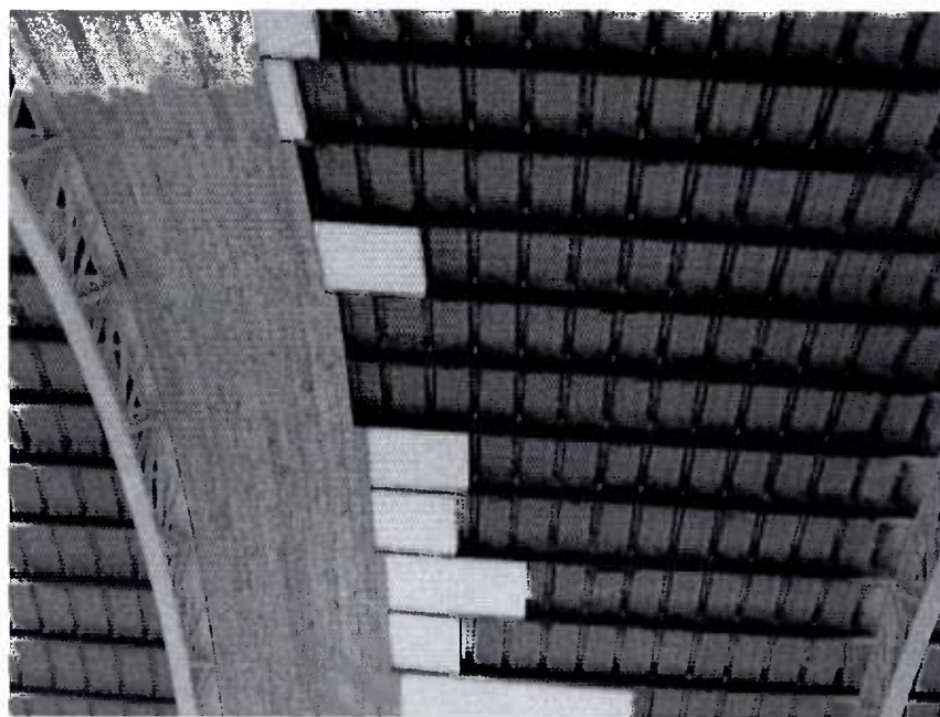
Aislación y cielo del comedor sin terminar.
